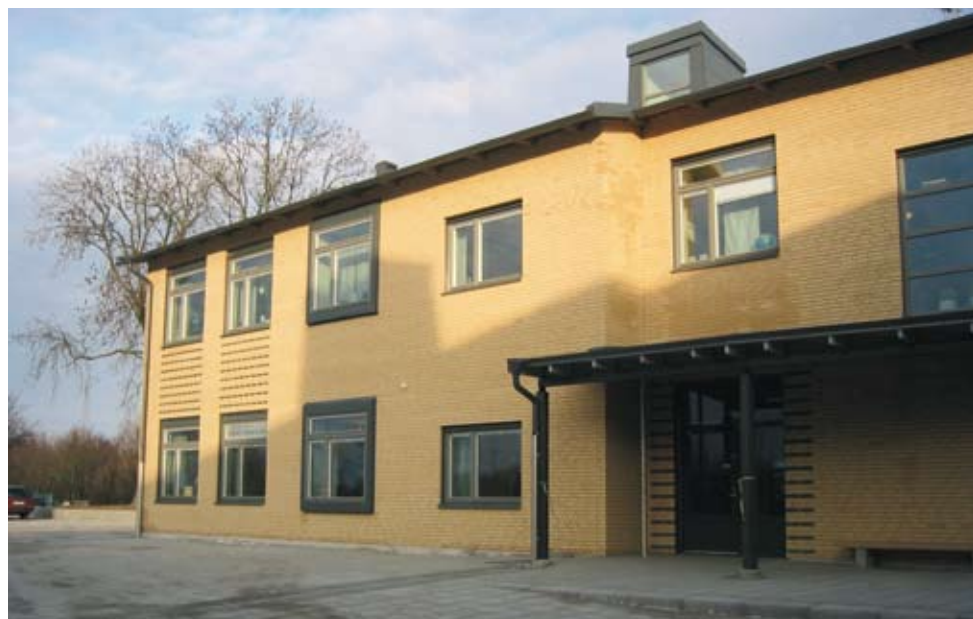
Figur 1. Östra Skrävlinge skola, Malmö, ytterväggar av fasadtegel, isolering och bakmur av lättklinker. Byggår: 2003, arkitekt: FFNS.
